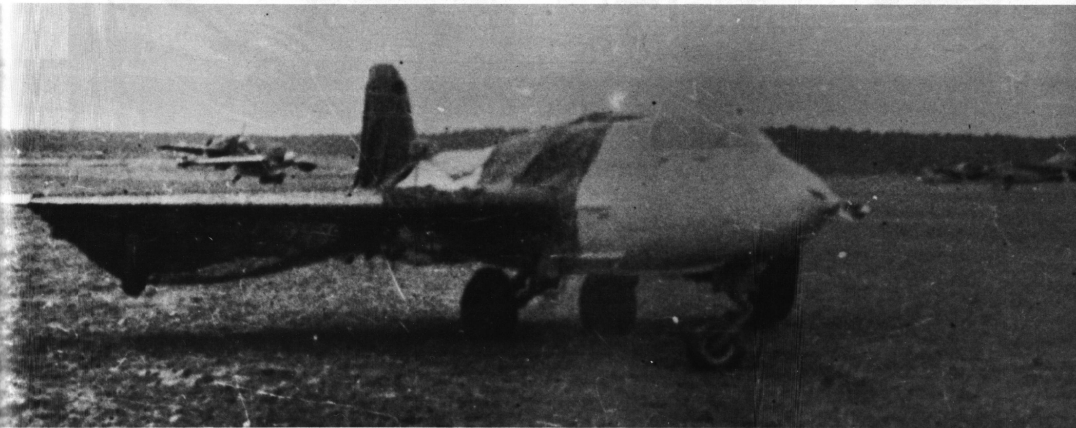
Erprobungsmuster der Me 163 B mit verlängertem Rumpf und Bugrad für Vorversuche zur Me 263. An der Rumpfunterseite sind die Verstärkungsleisten erkennbar. Im Hintergrund eine Me 163 A.
